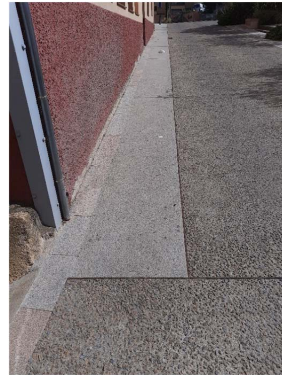
Figura 14. Detall paviment existent vial Plaça del Ramal, vial rentat a l'àcid, vorera de formigó i encintat unió vorera façana amb llosa de pedra granítica.
